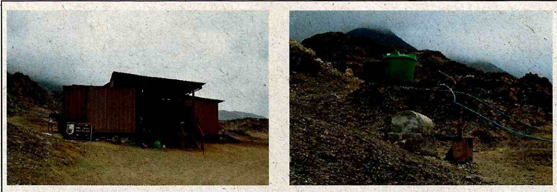
Imagen N° 3: Infraestructura administrativa PN Morro Moreno
