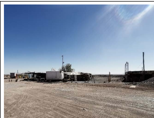
Fotografía N° 13: Instalación de faenas fuera del polígono autorizado, expediente N° 1AR12554.
