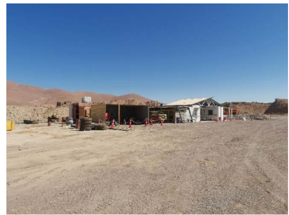
Fotografía N° 10: Instalación de faenas fuera del polígono autorizado, expediente N° 1AR10823.
