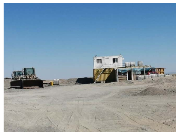
Fotografía N° 20: Extracción irregular, expediente N° 1AR10379.
