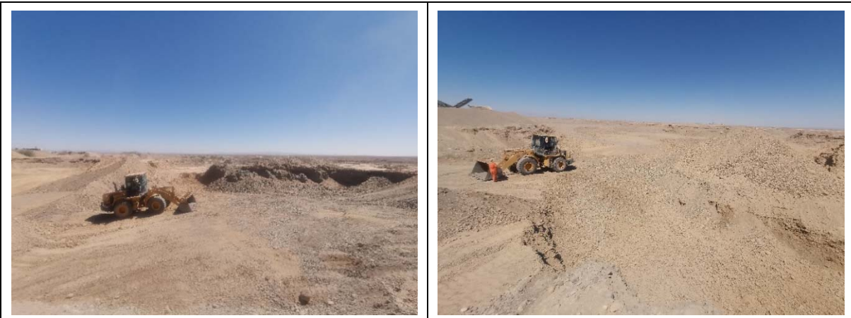
Fotografía N° 5: Extracción fuera del polígono autorizado, expediente N° 1AR10364.
