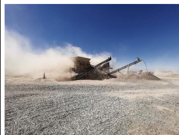
Fotografía N° 15: Extracción irregular, expediente N° 1AR8894.
