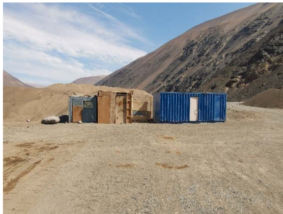
Fotografía N° 40: Instalación de faenas sector Chiza.
